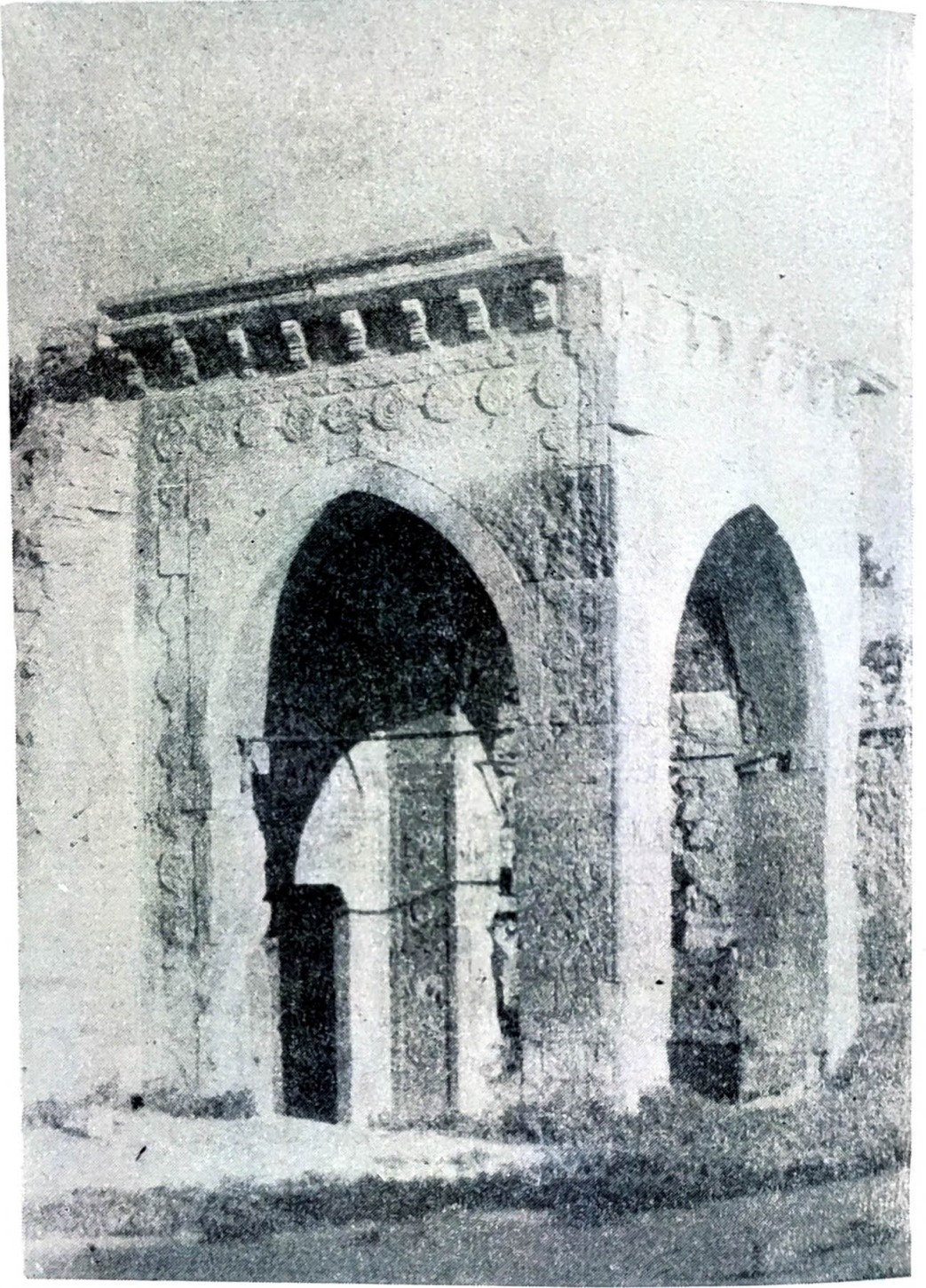
Рис. 19. Колокольня церкви Зораварк в Феодосии. Общий вид с север-запада.
