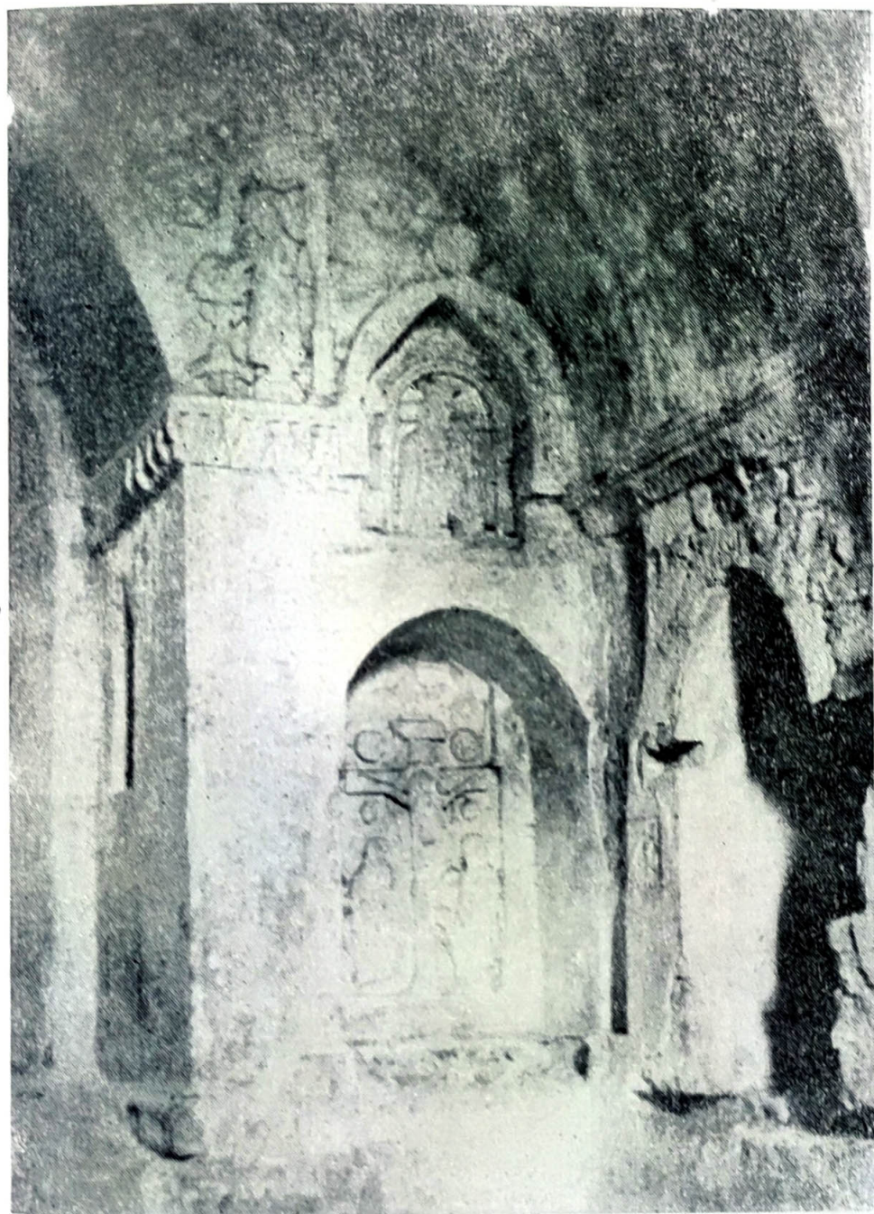
Рис. 15. Фрагмент юго-восточного угла интерьера монастырской церкви XIV в. в селе Бахчи-Эли в Крыму.
