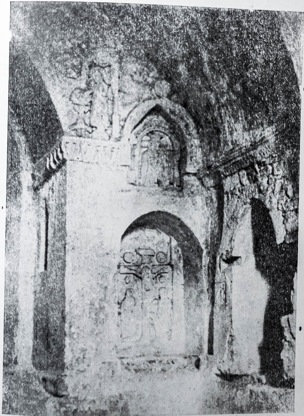
Рис. 15. Фрагмент юго-восточного угла интерьера монастырской церкви XIV в. в селе Бахчи-Эли в Крыму.
