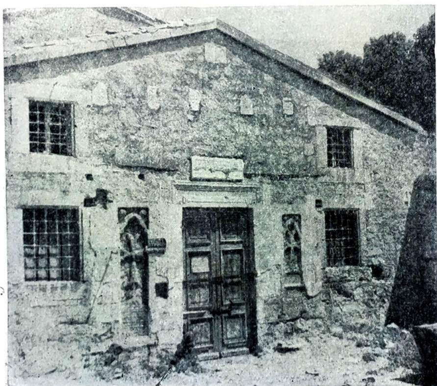
Рис. 25. Западный фасад притвора церкви Зораварк в Феодосии.
