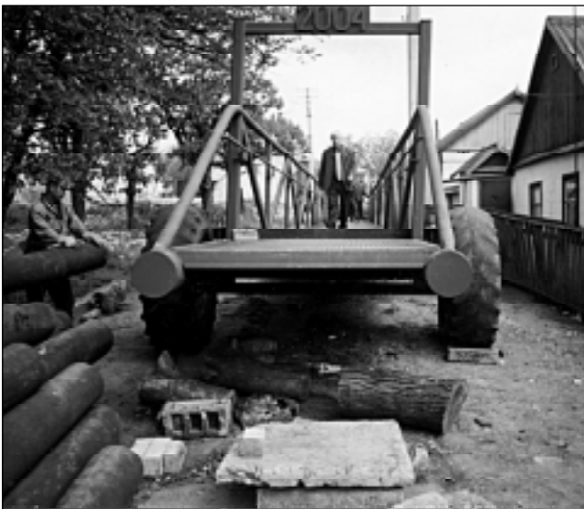
Строительство моста. 2004 г. СКЕМ. Фонды. № 214-Ф.
