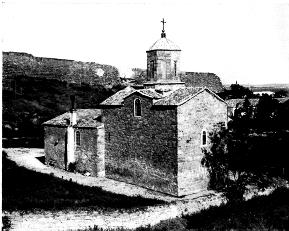
Рис. 8. Церковь Иоанна Предтечи. Общий вид с юго-восточной стороны.
