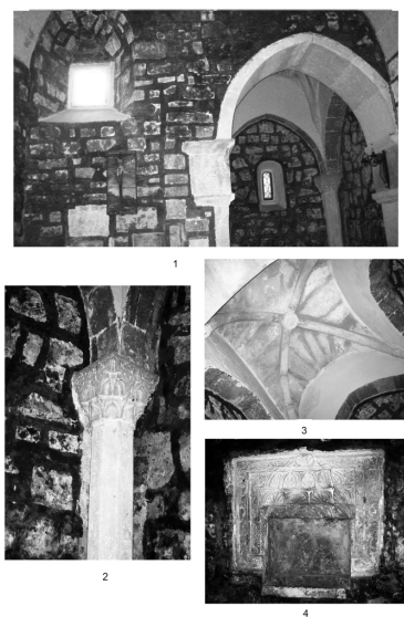
Рис. 8. Каффа, церковь Св. Сергия (Саркиса): 1 – интерьер северной церкви; 2 – колонна в алтарной части; 3 – крестовый свод над алтарной частью; 4 – крещальная ниша.
